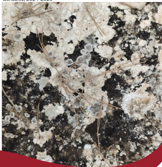
Fig. 3. Imagen ejemplo del inicio de degradación por oxidación en el soporte. [Macrofotografía] © Ruth Beatriz Acuña González, 2024-2025
